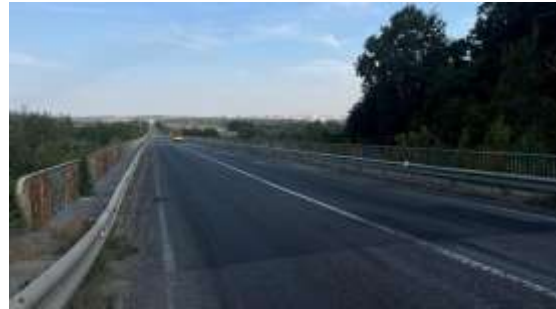
Рис. 1. Вид на мостовий перехід
