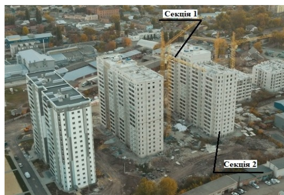
Рис. 6. Секції житлового будинку, осідання яких визначались
