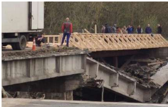
Рис. 4. Улаштування легкого дерев'яного настилу зверху прокатних двотаврових балок на автомобільній дорозі Н-27 Чернігів – Мена – Сосниця – Грем'яч [5]
