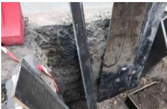
Рис. 11. Шари дорожнього одягу на мосту завтовшки до 60 см
