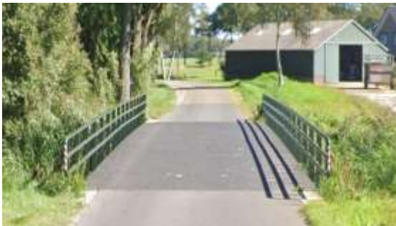
Рис. 9. Готова до експлуатації споруда з новим мостовим полотном із панелей FRP, с. Хогенвег, Нідерланди [15]
