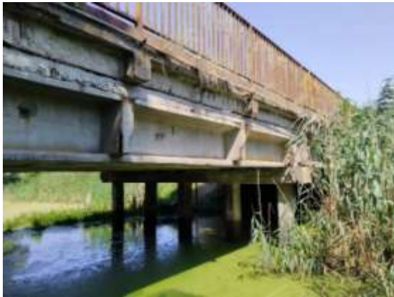
Рис. 10. Загальний вигляд мосту з низового боку
