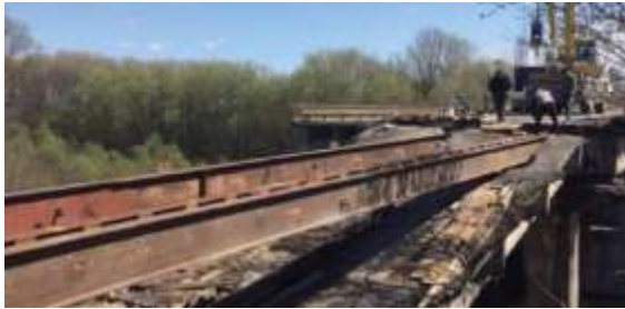
Рис. 3. Улаштування прогонової будови з металевих прокатних двотаврових балок по наявних опорах на автомобільній дорозі Н-27 Чернігів – Мена – Сосниця – Грем'яч [5]
