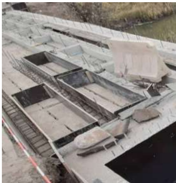
Рис. 13. Армування та бетонування ребер плити
