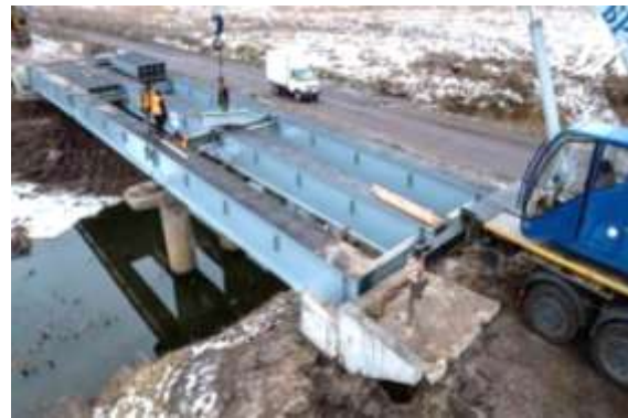
Рис. 1. Монтаж балок UNIBRIDGE® на наявні опори зруйнованого мосту [3]
