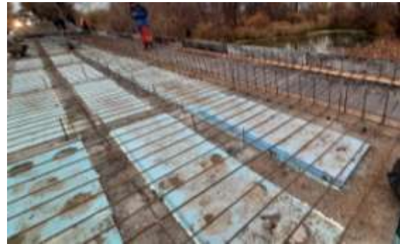
Рис. 14. Комірки, заповнені пінополістиролом
