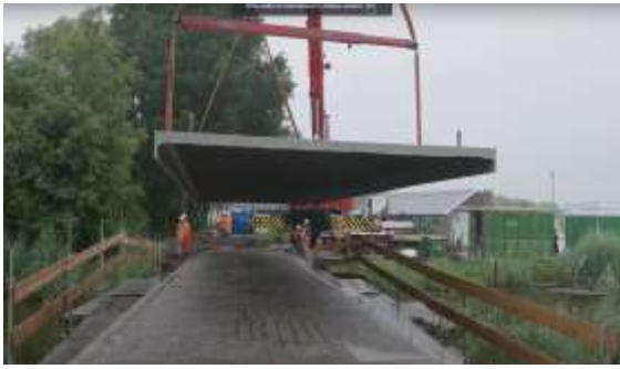
Рис. 8. Процес монтажу композитної панелі FRP на наявну прогонову будову мосту, с. Хогенвег, Нідерланди [15]
