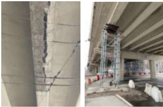
Рис. 1. Шляхопровід по проспекту Перемоги біля станції метро «Нивки» за три роки після капітального ремонту
