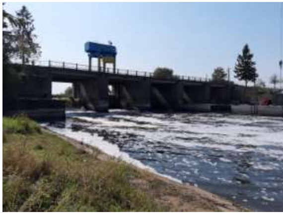
Рис. 1. Загальний вигляд мосту (на задньому плані видно кран греблі)
