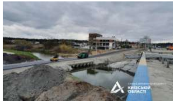
Рис. 1.7. Тимчасова переправа крізь річку Ірпінь (м. Ірпінь)
