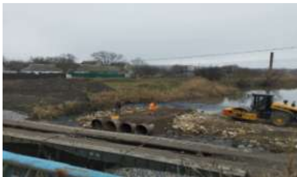
Рис. 1.9. Тимчасова переправа, автомобільна дорога Р-81
