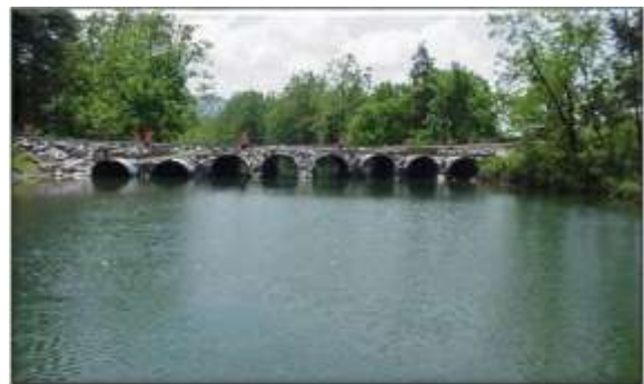
Рис. 1.2. Тимчасовий перехід крізь річку
