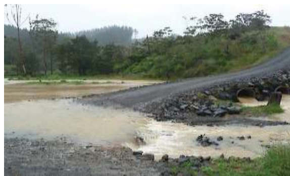
рис. 1.3. Тимчасовий перехід із переливною частиною
