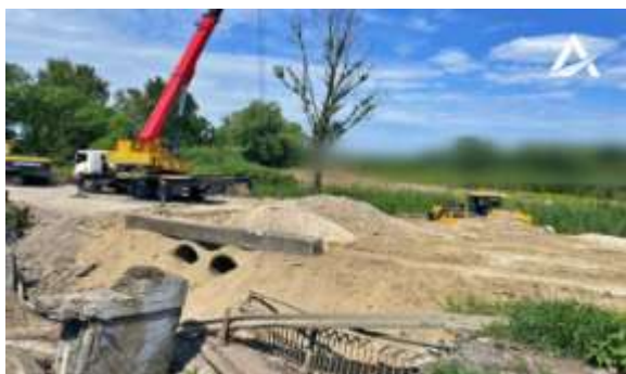
Рис. 1.10. Тимчасова переправа, автомобільна дорога Н-07
