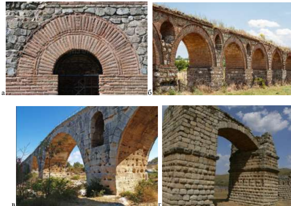
а – римське склепіння; б – акведук біля м. Скоп'є (Північна Македонія); в – міст Юліана (Франція); г – міст Алконетар із сегментною аркою (Іспанія)
