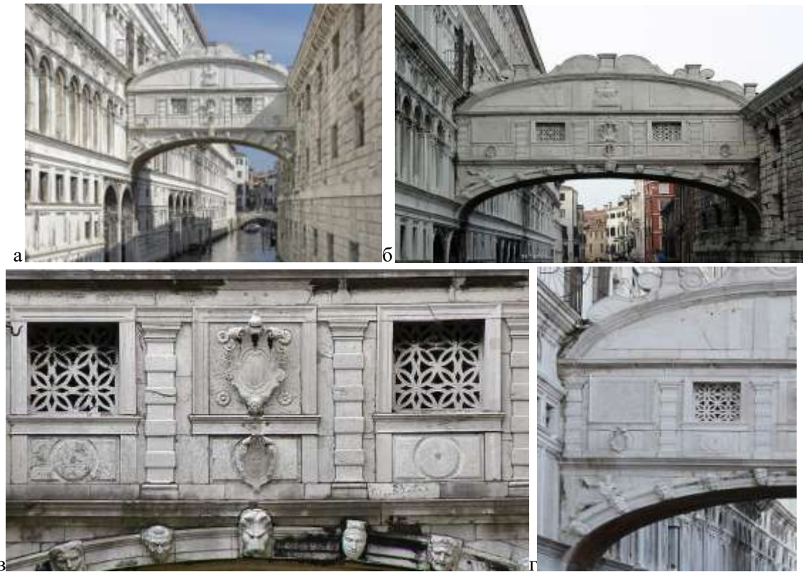
а, б – загальний вигляд; в, г – елементи декору мосту
