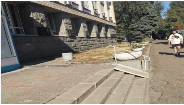
Рис. 4. Пандус до навчального корпусу № 4 НТУ «Дніпровська політехніка», м. Дніпро
