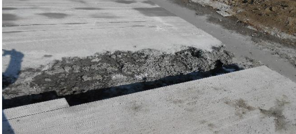
Рис. 1. Обрізання країв бетонної смуги після зупинки укладача
