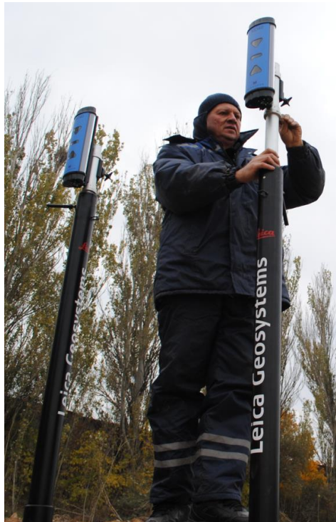
Рис. 1. Установлення систем машинного контролю Leica Geosystems на бульдозер Liebherr
