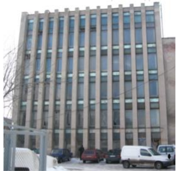
Рис. 1. Загальний вигляд споруди до реконструкції
