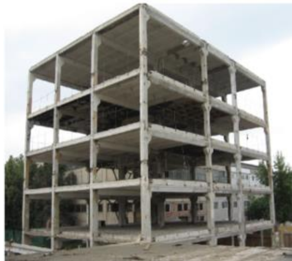
Рис. 2. Загальний вигляд існуючого каркаса після демонтажу конструкцій фасаду
