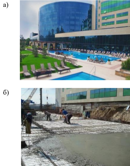
Рис. 18. Розважальний комплекс «Місто», м. Харків: а – загальний вигляд; б – конструкція фундаментної плити
