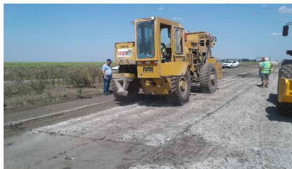
Рис. 4. Робота віброрезонансного бетонолому RB-500 по бетонних плитах
