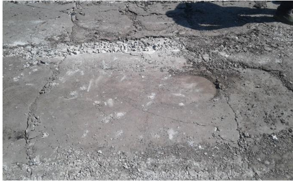
Рис. 5. Стан бетонного покриття після віброрезонансного бетонолома RB-500
