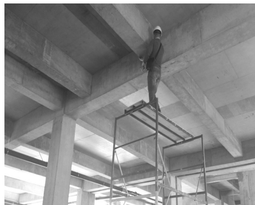
Рис. 3. Дослідження технічного стану залізобетонного перехресно-ребристого перекриття
