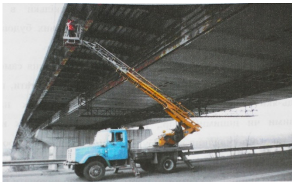
Рис. 7. Закріплення струни (дроту) датчика деформації на балці шляхопроводу
