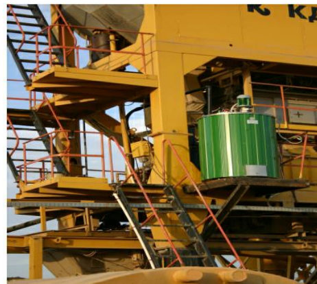
Рис. 6. Зовнішній вигляд асфальтозмішувальної установки
